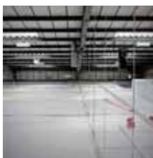
Armatures Unités clim Signalétique
